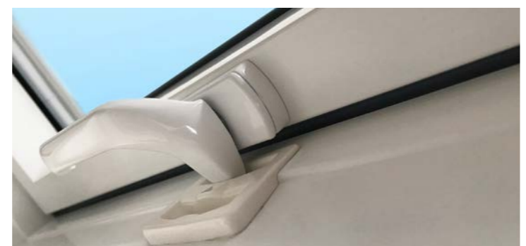
Particolare della maniglia in posizione di microventilazione
